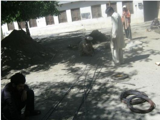
Afb. Aanbrengen staal voor fundering
